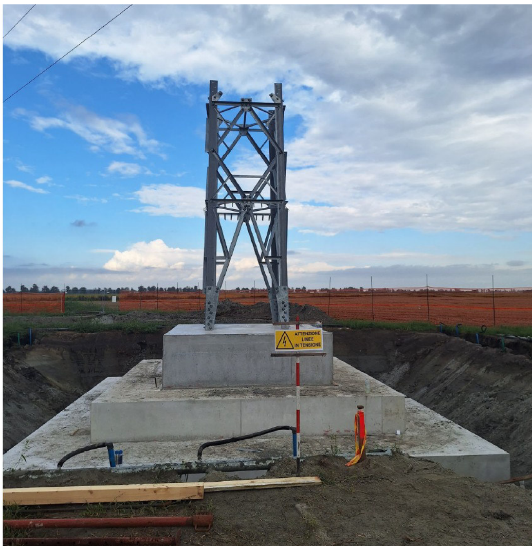
Figura 4.53: Esempio fondazione monoblocco
